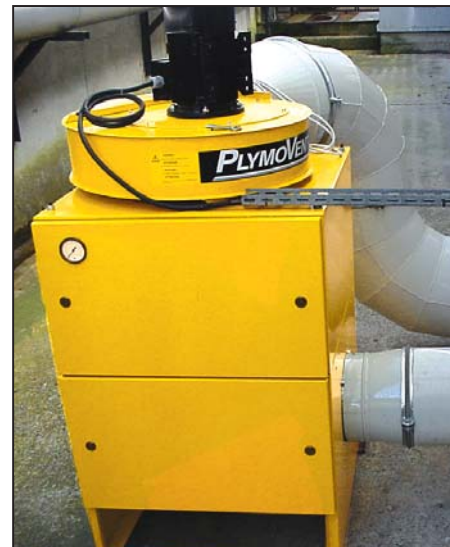
Filtro MistEliminator con cassetta autodrenante e prefiltro a 3 stadi, fino a 1000 m 3 /h
